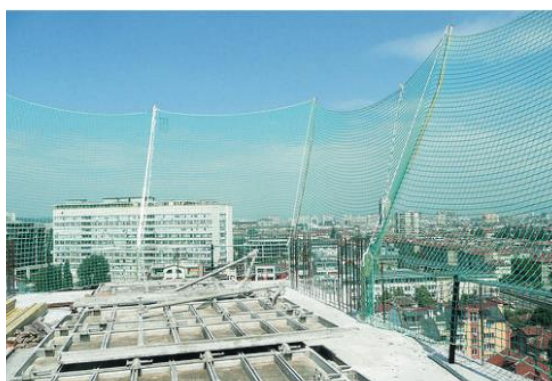
Esempi di utilizzo delle reti di sicurezza tratti dalla Guida INAIL
