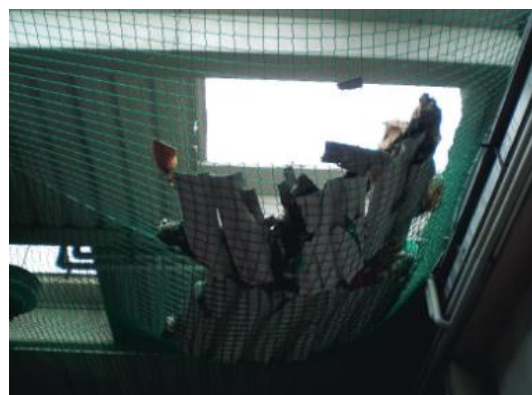
Esempi di utilizzo delle reti di sicurezza tratti dalla Guida INAIL
