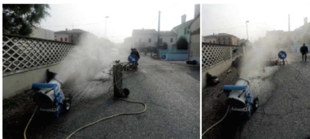
Figura 5 - Cannone nebulizzatore nell'area d'intervento.
