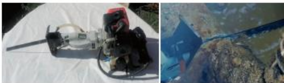
Figura 7 - Taglio di una tubazione mediante seghetto alternativo a motore (a scoppio) a bassa velocità di rotazione.
